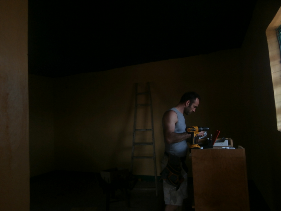
Al buio ... l'elettricista si è messo subito al lavoro
