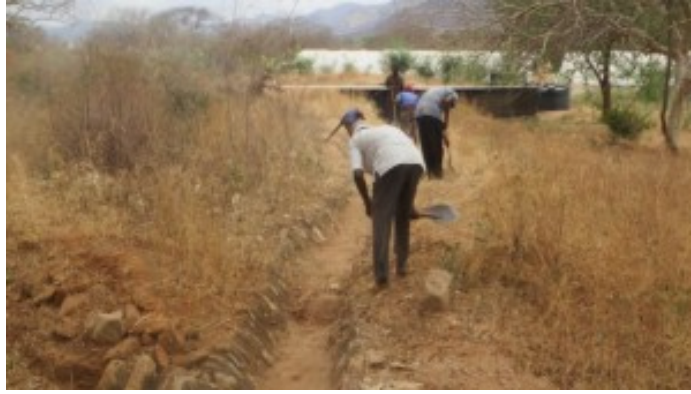
la pulizia delle canaline di raccolta dell'acqua piovana
