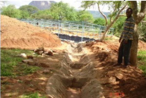
13-canaline per raccogliere ed incanalare l'acqua piovana
