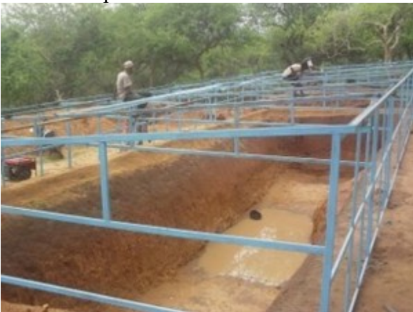
7-costruzione tetto per ulteriore raccolta acqua piovana
