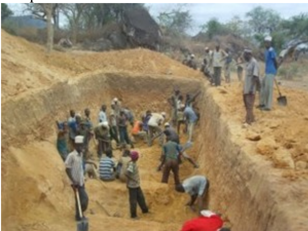
3-si iniziano gli scavi
